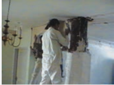
شکل ۴-۸- نحوه‌ی اجرای قوس گچی روی زمین به کمک رابیتس (چپ) و نصب آن در محل (تصویر راست)
