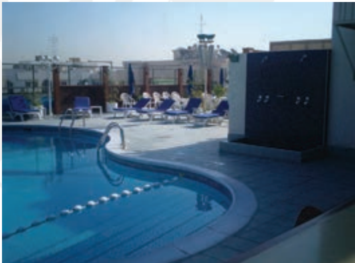
شکل ۲-۱۳- عایق‌کاری مناسب امکان ساخت استخر در پشت‌بام را میسر ساخته است.
