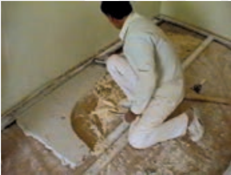
شکل ۴-۸- نحوه‌ی اجرای قوس گچی روی زمین به کمک رابیتس (چپ) و نصب آن در محل (تصویر راست)
