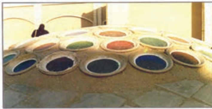
شکل ۲-۱۲- استفاده از گلجام در بازسازی سقف حمام
