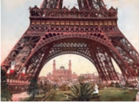
شکل ۲-۱۰- برج ایفل در حال ساخت - پاریس ۱۸۸۹ میلادی
