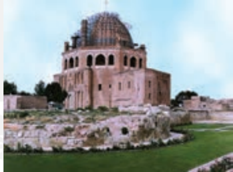
شکل ۳-۶- سلطانیه (بزرگ‌ترین گنبد آجری جهان) با ۲۶ متر قطر و ۵۱ متر ارتفاع از رأس آن تا سطح زمین
