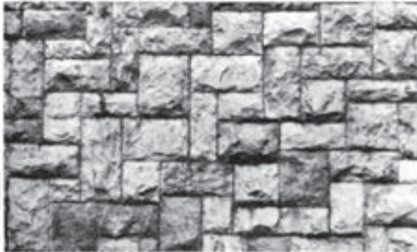
شکل ۹-۴- استفاده از سنگ بادبر در نما
