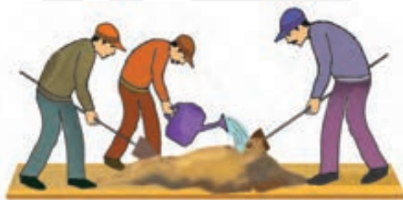
شکل ۳-۷- سرن‌کردن ماسه و مخلوط کردن ملات
