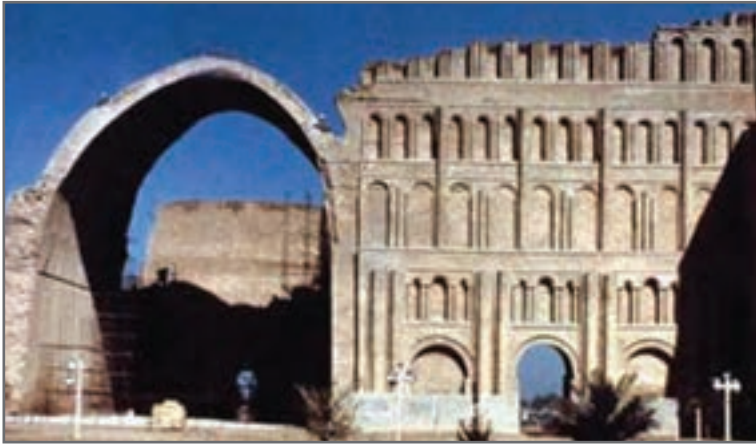
تصویر شماره ۲۸-۲- تاق کسری یا ایوان مدائن، نمونه بارز تاق آهنک در دوران پیش از اسلام
