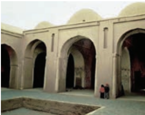
تصویر شماره ۹-۳-ج - دید داخل حیاط مسجد جامع فهرج
