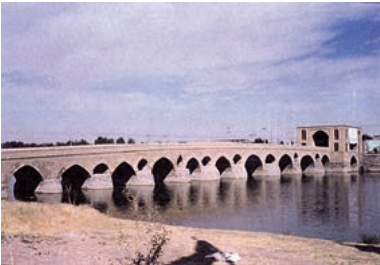
تصویر شماره ۴-۱۹ - پل شهرستان بر روی رودخانه زاینده رود مربوط به دوره سلجوقی
